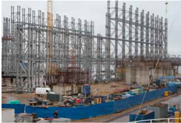
На «Северной верфи» продолжается строительство эллинга / Фото: Корабел.ру
