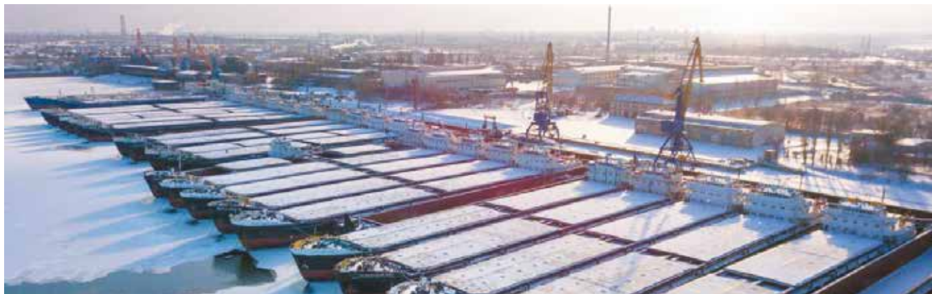
Отстой флота в межнавигационный период у причальной стенки Волжского судостроительно-судоремонтного завода. Фото: vggg.ru
