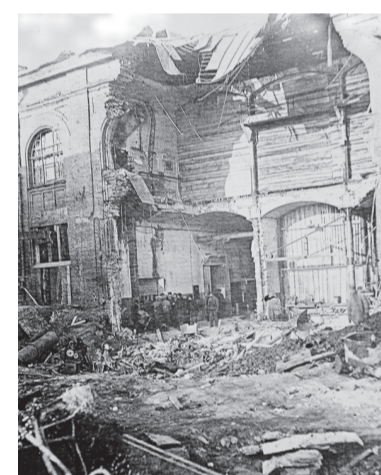
Разрушения в цехе №5
