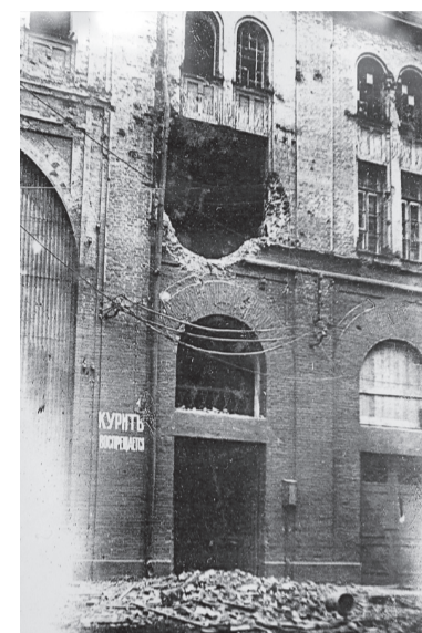
Разрушения в цехе №7
