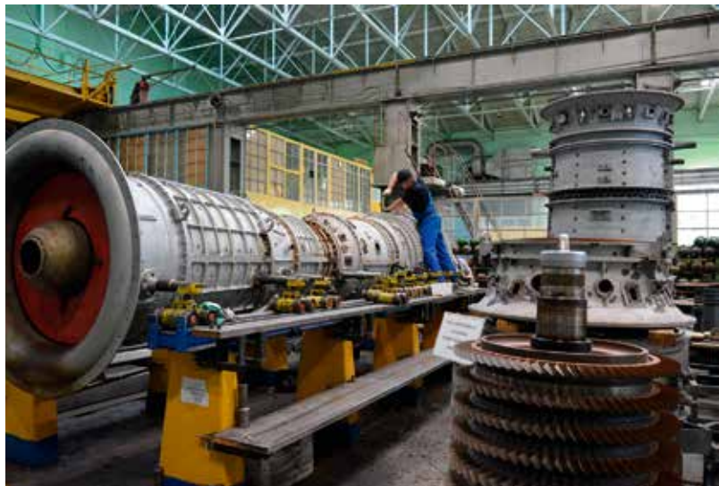
В турбинном цехе / Фото: Корабел.ру
