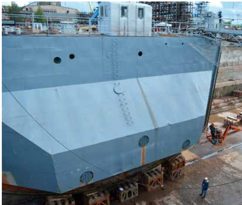
Ремонт батопорта дока им. Сургина / Фото: Кронштадтский морской завод
