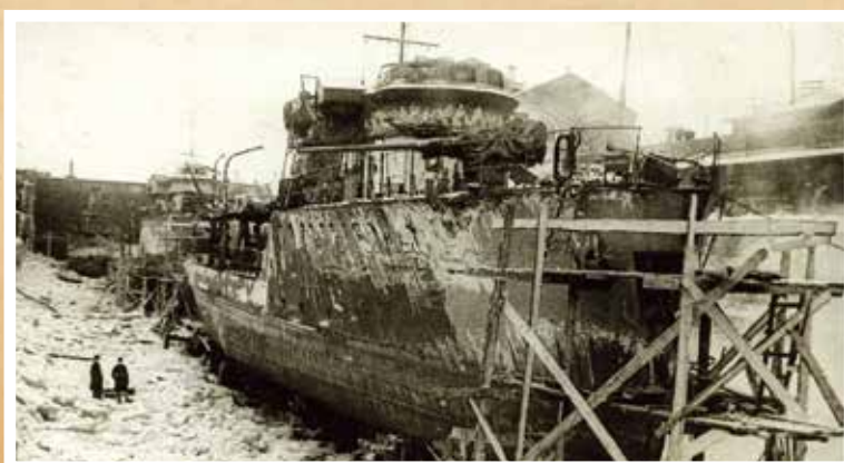
Зимний ремонт в доке Морзавода
